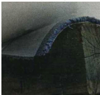
Suojaa sivutuet/pukit paksulla kokolattiamatolla ja kahdella kerroksella polyeteenimuovia, jotta B-Free Explore -pinnoite ei vaurioidu.
